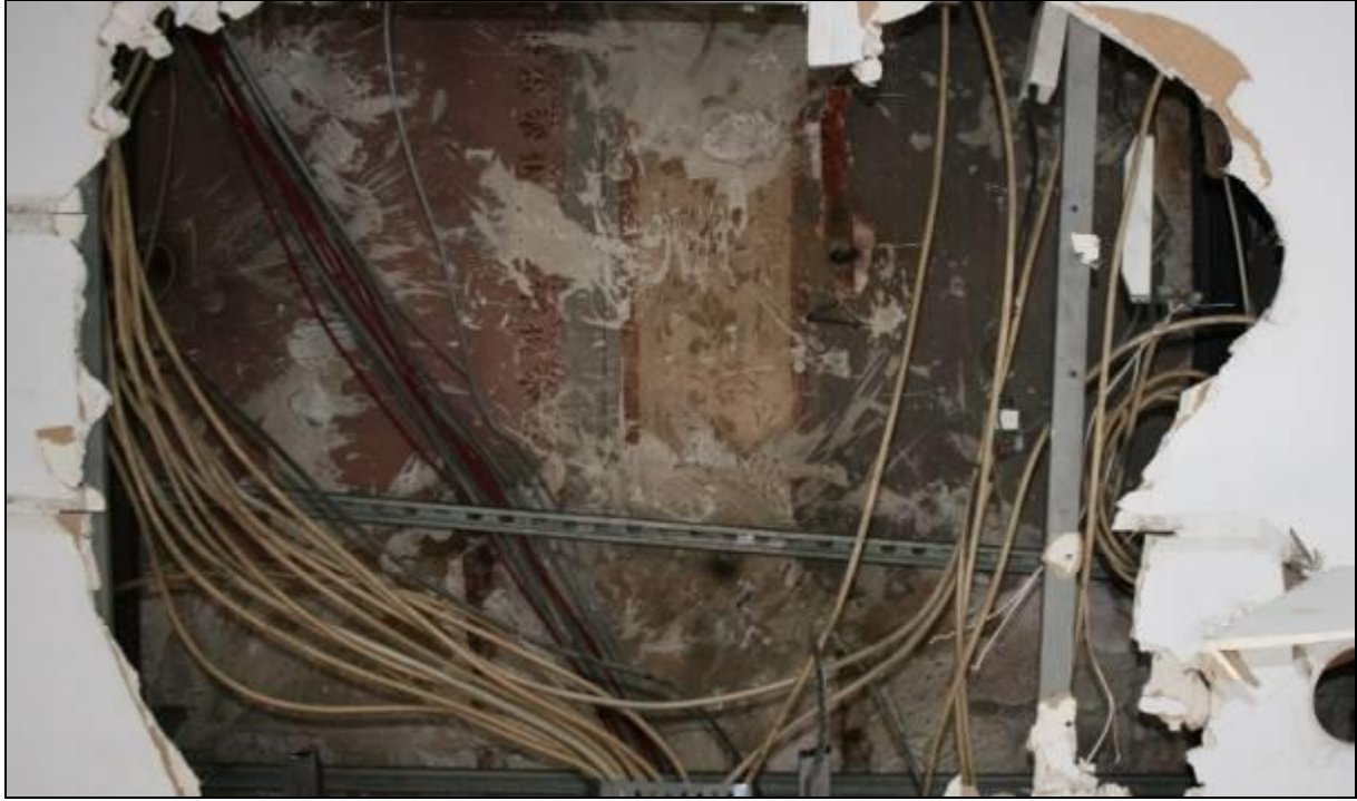
Fotoğraf 6. Zemin Kat Dükkanının Asma Tavanı Altında Yer Alan Kalemşi Tavan ( Arcadia Mimarlık)
