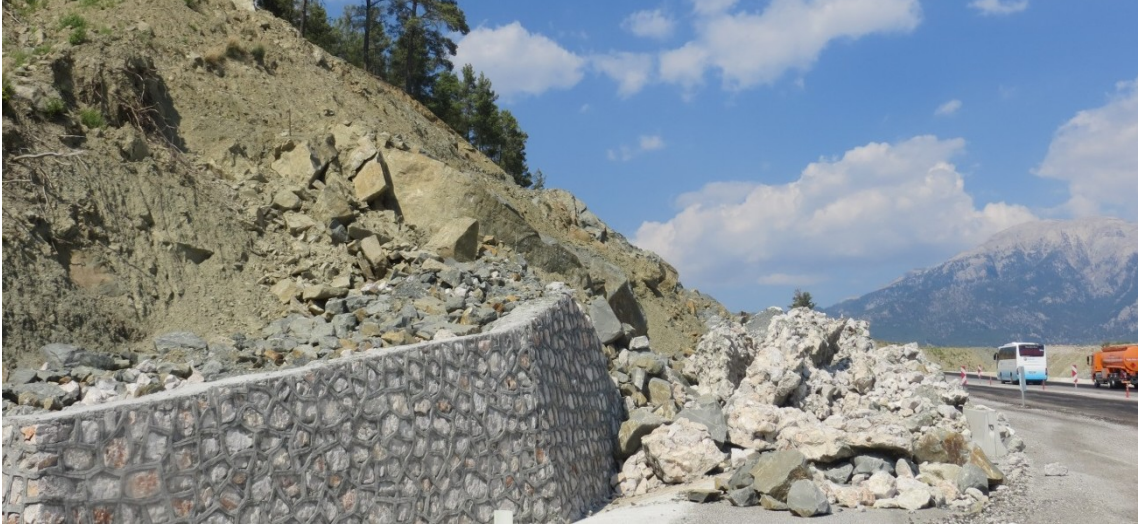
Fotoğraf 3. Kemer-Antalya Karayolunun 10. Kilometresinde Zaman Zaman Meydana Gelen Heyelan Sonucu Karayolu Trafiđi Aksamaktadır.
